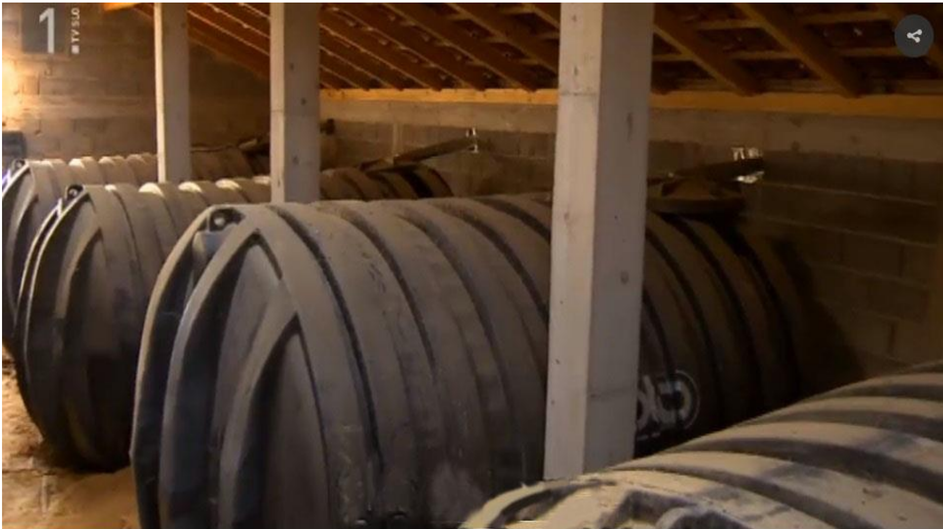
Zatvoreni rezervari 8 komada zapremine 12 000 litara medusobno povezani
